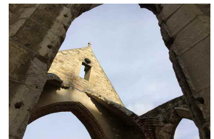
Ruine der Kapelle - Nachkriegszustand Fotografie | 2016
