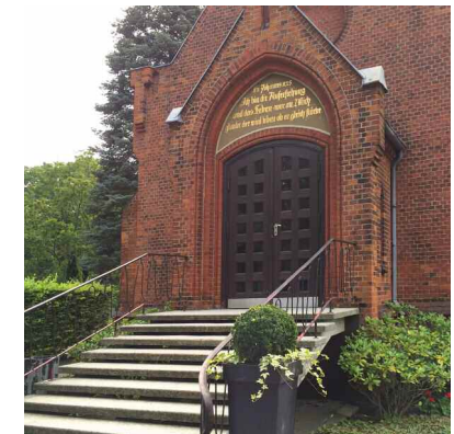
Friedhofskapelle | neue Eingangstreppe von Alfred Müller-Hoepe erbaut 1962 | Fotografie | 2015
